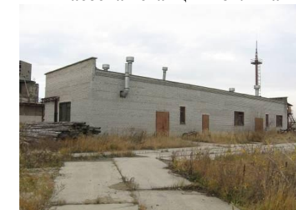
Насосная станция топлива
